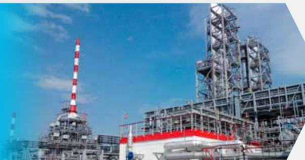
**Включение в схему переработки установки изомеризации фракции 70-105°C позволяет производить автобензины по стандарту ЕВРО-5 без использования алкилата и бензина каталитического крекинга**
